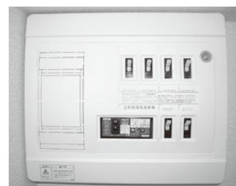
Favor verificar o disjuntor do lado exterior do apartamento. Quando o disjuntor geral cair, não será possível ver televisão e as lâmpadas dos corredores irão se apagar.
